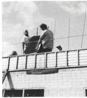
Regi and Matthew pour cement into the form.
